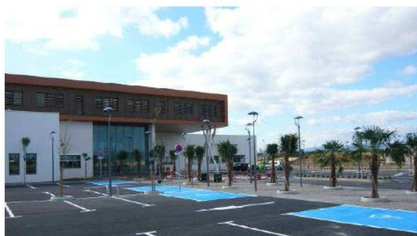
Pole logistique de l'hôpital de Carcassonne
