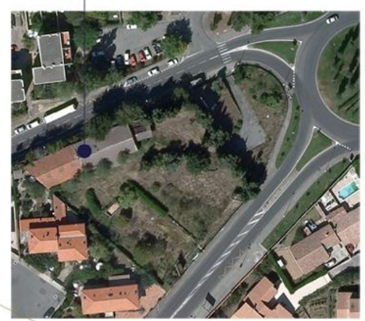
Bâtiment à démolir vue de dessus
